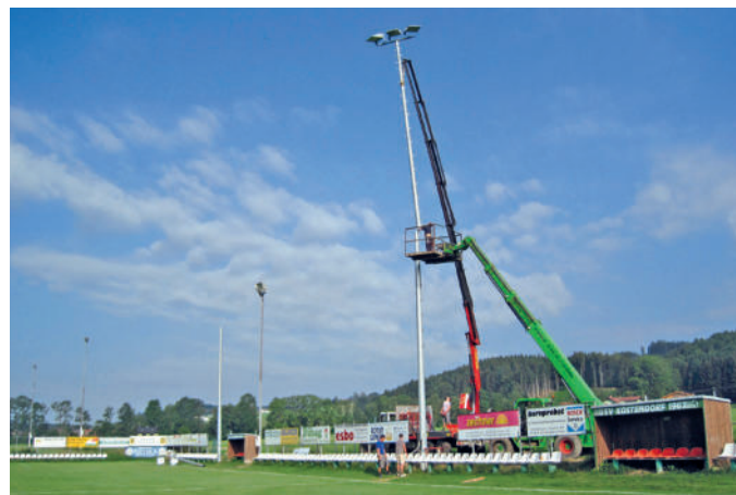
Installierung der neuen Flutlicht-Anlage 2010
